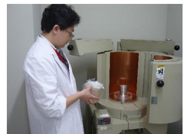
ゲルマニウム半導体検出器の重さは1トン以上。わずかな面積に大きな荷重がかかるため、床が抜けないように補強されています。
