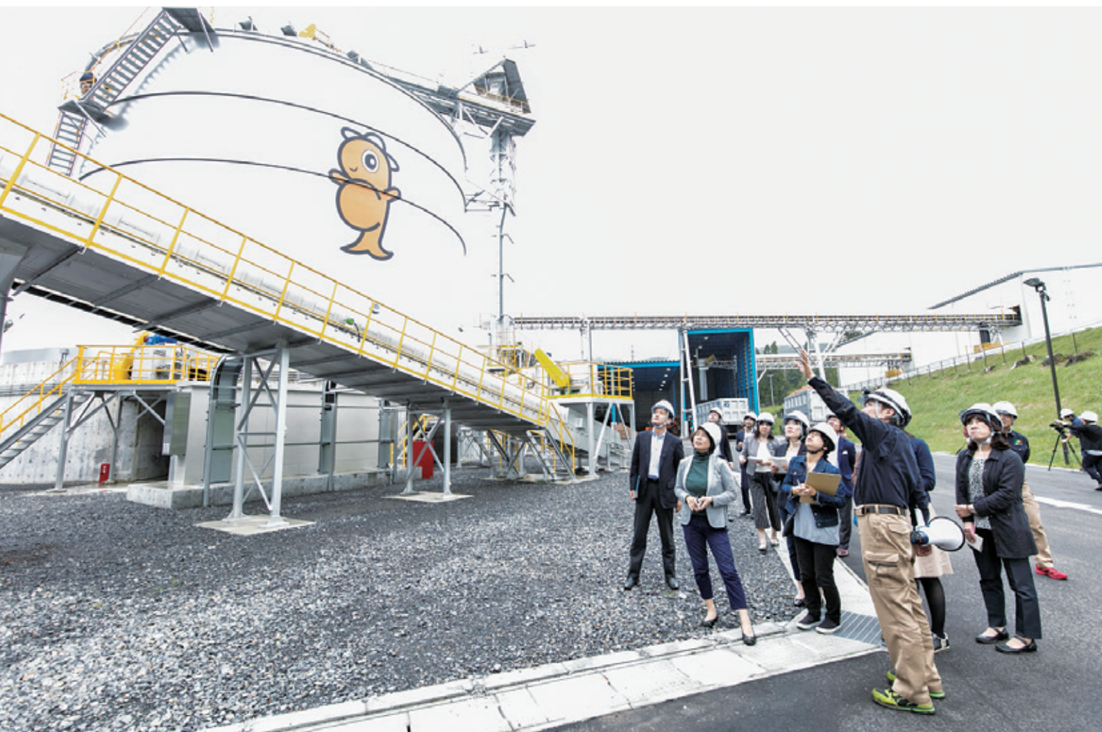
2016年9月、岩手県野田村にある野田バイオマス発電所を生協の役員などが視察訪問した（関連記事はP4を参照）。
