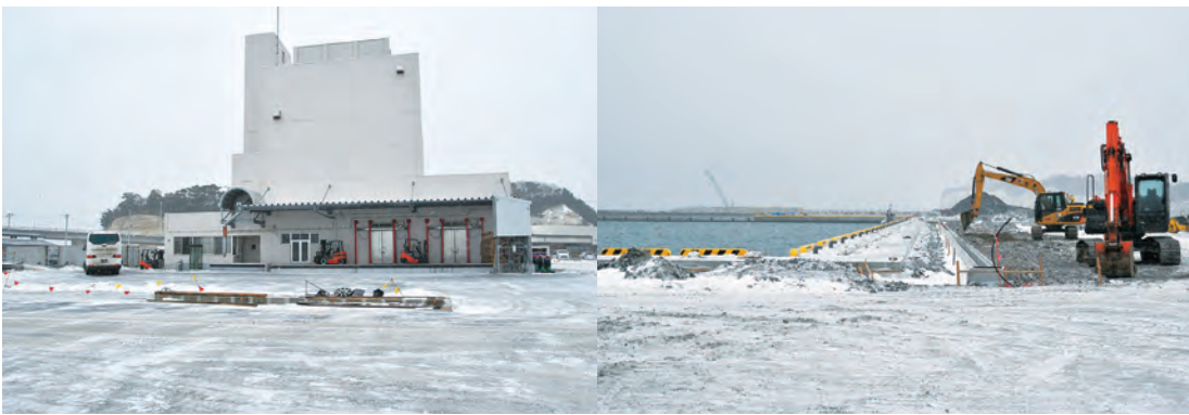
新しく建てられた製氷工場。
