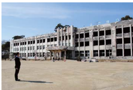
津波と火災で使えなくなった石巻市立門脇小学校。
