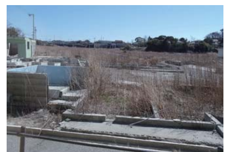
建物の基礎だけになった場所には 雑草が生えていた (南相馬市)。
