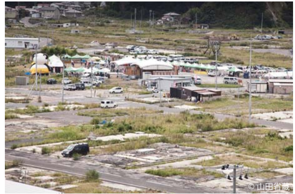
山田町では震災の傷跡がまだまだ目立つ。中ほどのテントが祭り会場。
