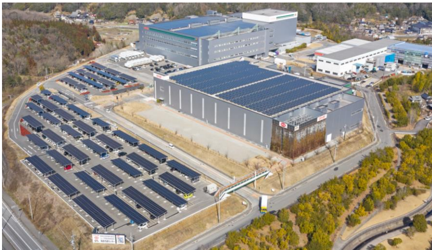
尾道ドライ流通センター・尾道冷凍流通センターの社員駐車場に設置された太陽光発電設備
