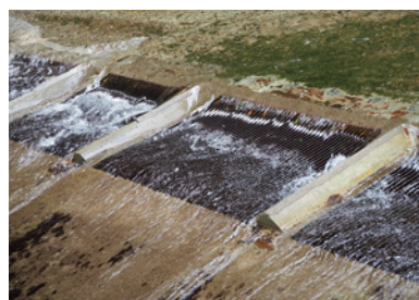
更スリット（隙間）を大きくし、より多くの水を取り込めるように改良されました
