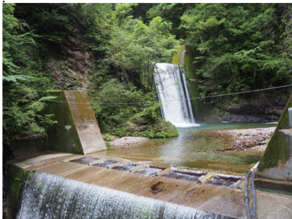
更新後小又川水力発電所取水口
