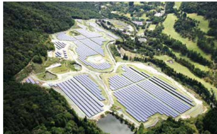
▲大阪いずみ市民生協の京都・亀岡太陽光発電所。同生協の「コープでんき」には同発電所の電気も含まれます。
