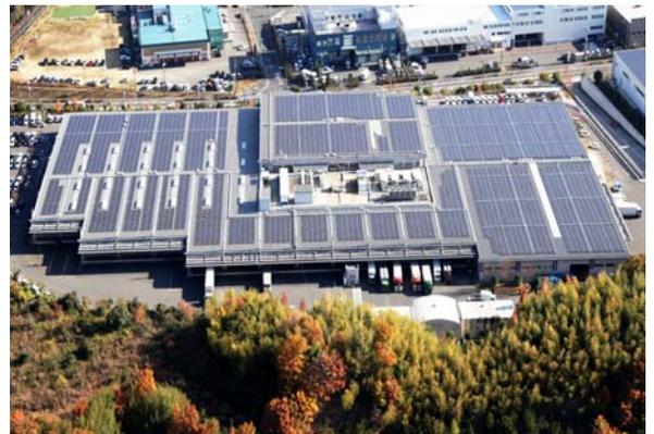
大阪いずみ市民生協・テクノステージ物流センター(和泉市)の屋上に設置された5,474枚のソーラーパネル。総出力1.3MW。2012年11月より稼動中。
