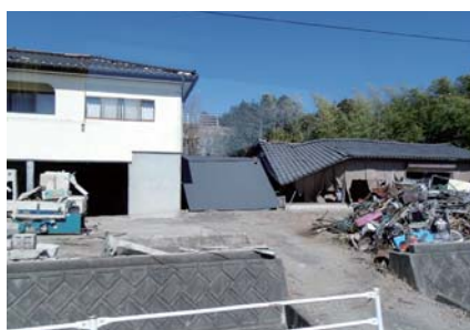
片付けが進まない倒壊した家屋 (南相馬市)。
