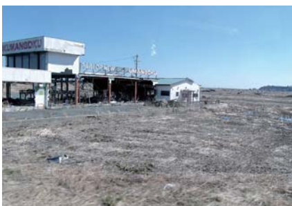
地盤沈下し、水たまりが所々見られる (南相馬市)。
