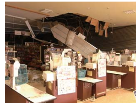
いばらきコープ・水戸店の様子。レジの上の天井が崩れ落ちた。
