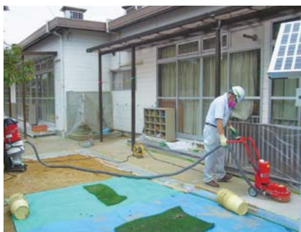
放射線量の高い場所は、研磨機で表面を削っていく。国際協同組合同盟（ICA）からの寄付で購入したという。
