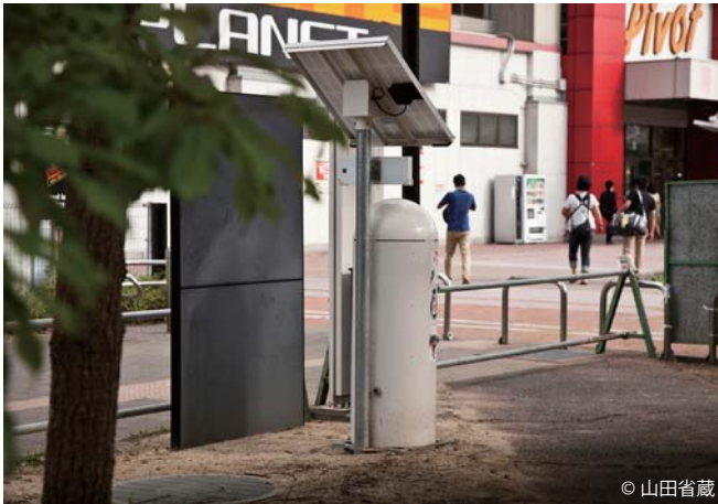
福島駅前に設置されたリアルタイム線量測定システム（写真中央の白の機材）。
