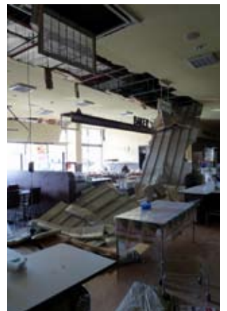
天井の崩落で特にひどかったのはパン売場の前。7~8mほどにわたって落ちたが、今はきれいに復旧した(写真左)。
