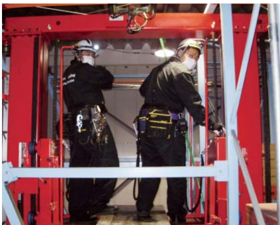
▲大きな余震後の自動倉庫の復旧作業
