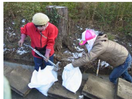
側溝の泥をかき出し、土のう袋につめる。 3時間で、250袋分の泥を清掃。
