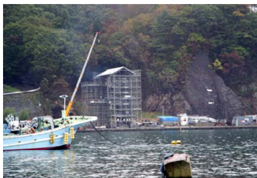
建設中の田老町漁協製氷工場。
